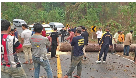
ภาพประกอบที่ 34. ต้นไม้ล้มกีดขวางถนนและทับสาย FRSS OFC ชำรุดเสียหาย
