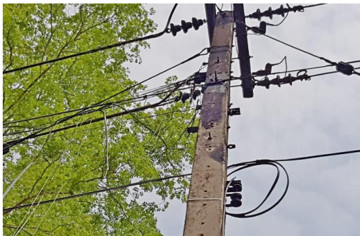
ภาพประกอบที่ 33. ตำแหน่งเสาไฟฟ้าที่ระบบไฟฟ้าบกพร่องเกิดประกายไฟไหม้มากจากแกนเสา
