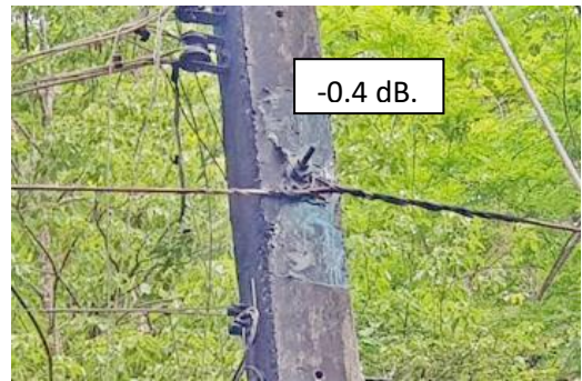
ภาพประกอบที่ 33. ตำแหน่งเสาไฟฟ้าที่ระบบไฟฟ้าบกพร่องเกิดประกายไฟไหม้มากจากแกนเสา
