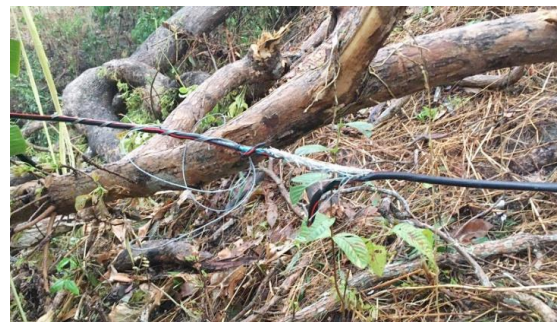
ภาพประกอบที่ 34. ต้นไม้ล้มกีดขวางถนนและทับสาย FRSS OFC ชำรุดเสียหาย
