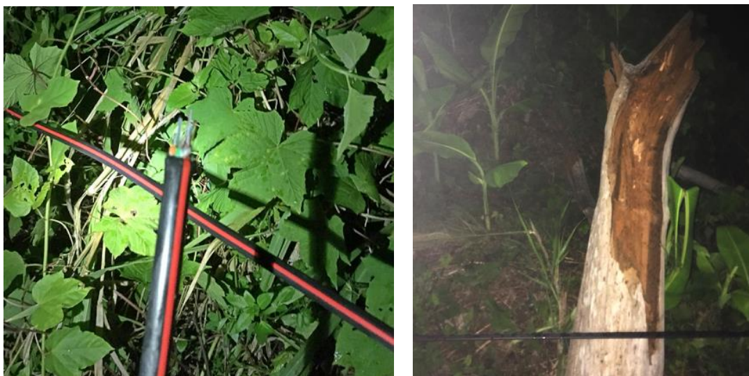
ภาพประกอบที่ 35. ต้นไม้ล้มทับสาย FRSS OFC ชำรุดเสียหาย
