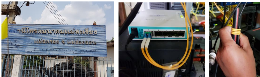
ภาพประกอบที่ 30. ทดสอบระบบ Alarm ชุมสายแม่สะเรียง แม่ลาน้อยและขุนยวม”
