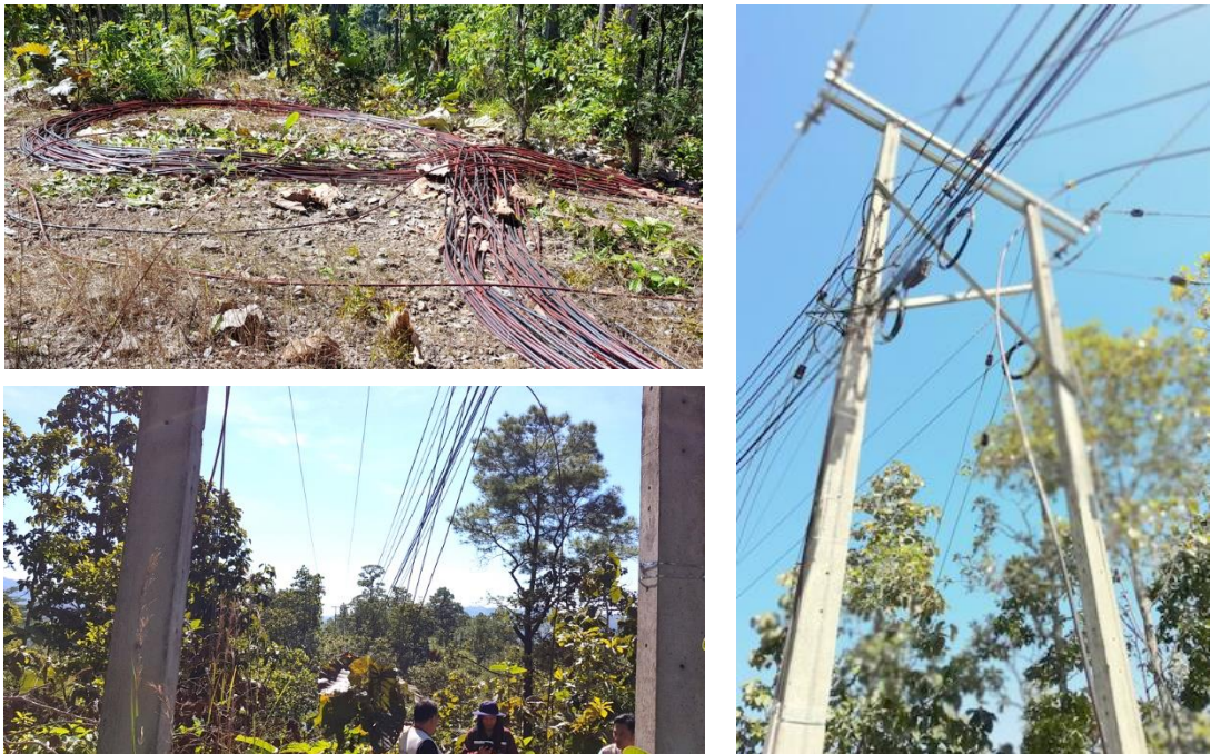
ภาพประกอบที่ 26. จุดพักสาย FRSS OFC เพื่อสะดวกในการติดตั้งและระยะห่างเสาไฟฟ้า
